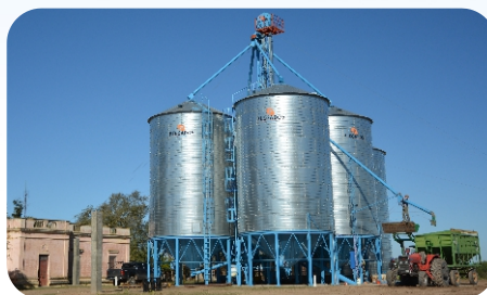
Sistema de aireación
